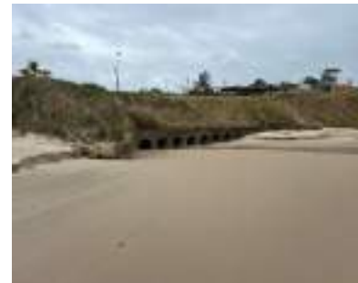
Descarga Av. Ciruelo de Japón y la rambla. 11 caños de 1000 mm. Los caños del lado izquierdo se encuentran obstruidos por arena.
