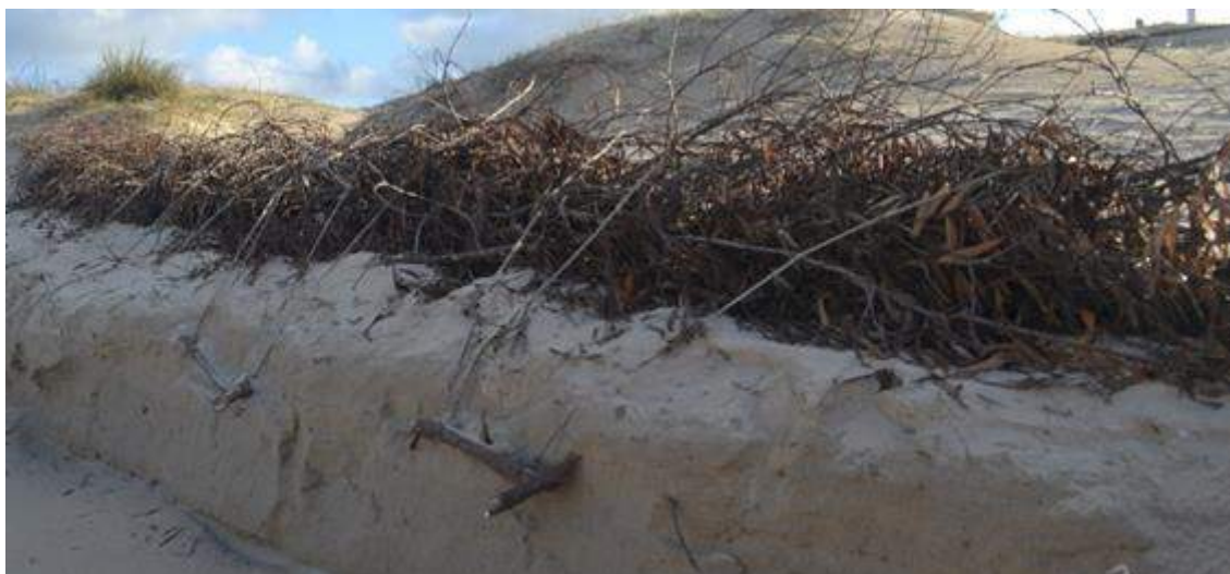
Figura 4-104 Corte de duna recuperada en experiencias anteriormente documentadas donde se aprecian anclajes y ataduras con hilo sisal.
