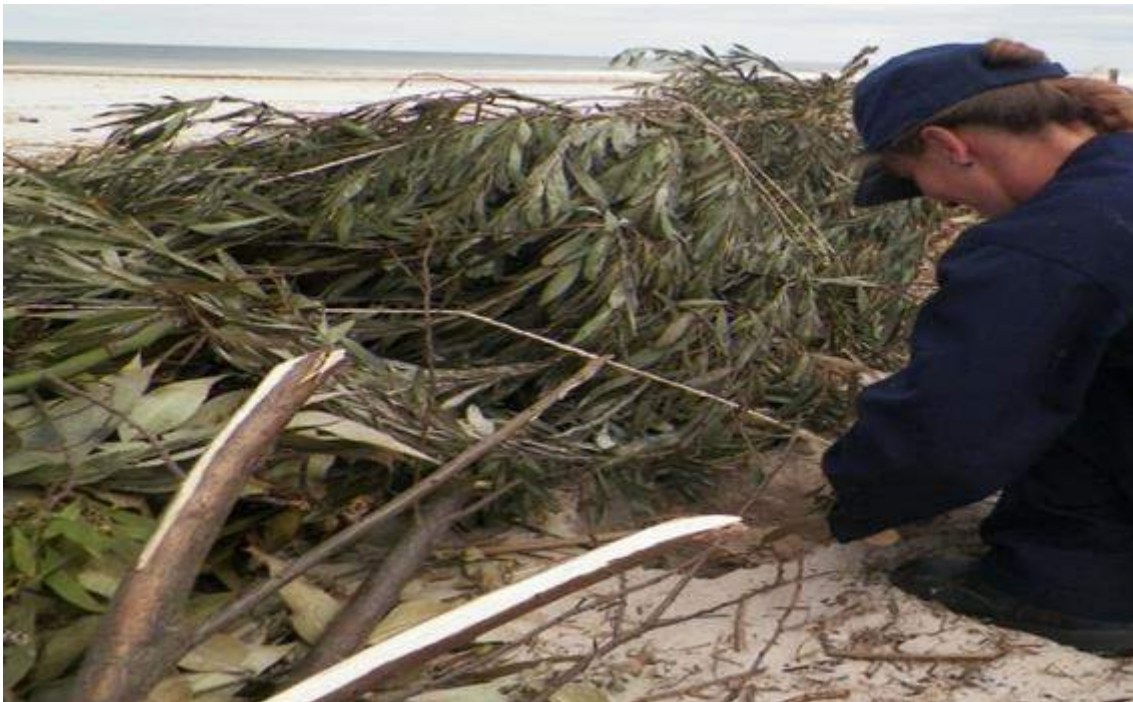
Figura 4-100 Atado de las podas y vista del detalle de cercas captoras (tomado de ficha técnica n°6 proyecto URU/07/2013)
