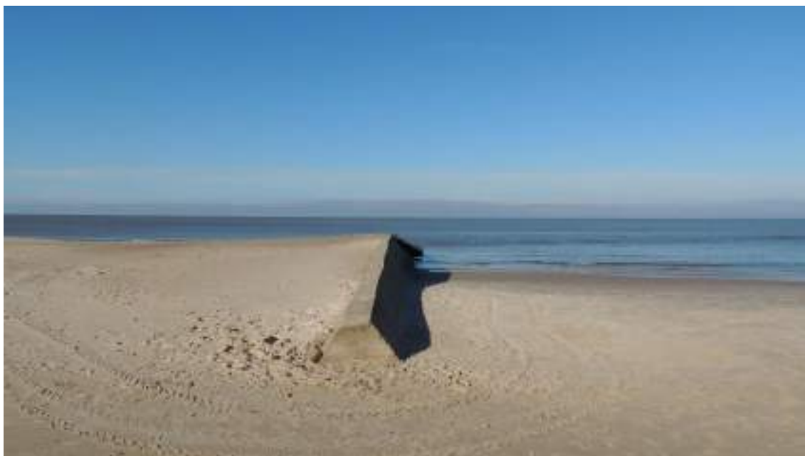
Figura 4-43: Espigón donde se evidencia acumulación de arena del lado Este.
