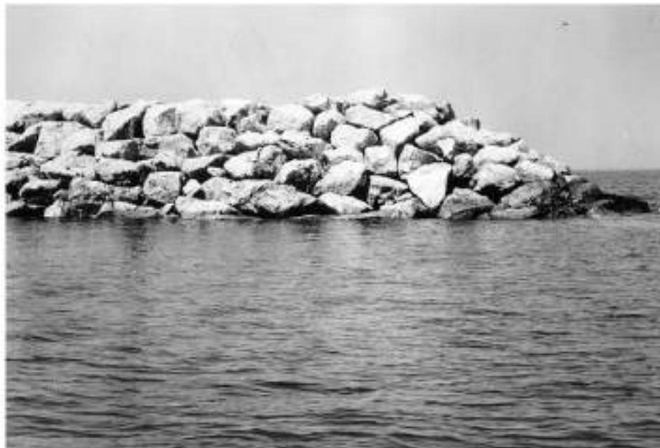
Figura 4-90 Ejemplo de enrocado colocado de forma selectiva (Figure VI-4-3 del Coastal Engineering Manual).
