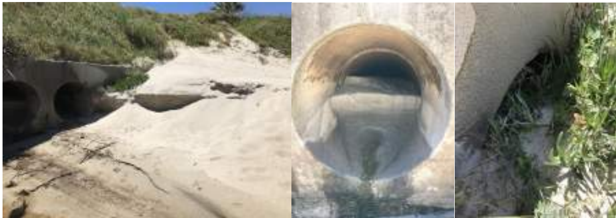
Figura 4-112: Fotografías de la descarga 7 donde se observa que 5 bocas se encuentran obstruidas. (Fecha: 6/11/23).
