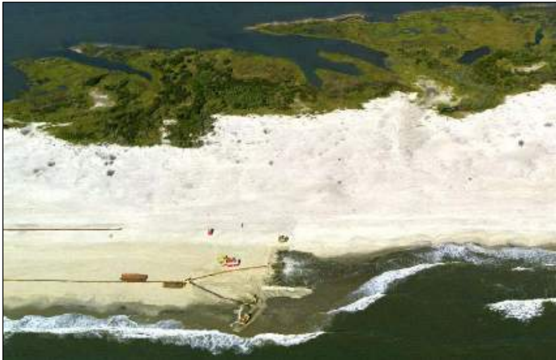
Figura 4-93 Ejemplo de proceso constructivo de relleno de playas (tomado de https://www.nps.gov/articles/beach-nourishment.htm ).
