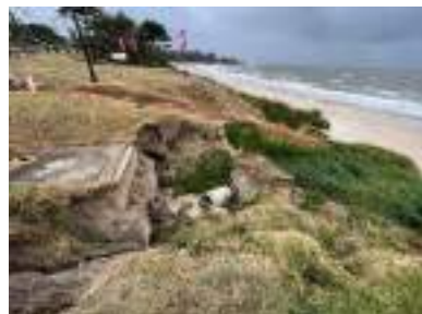
Descarga pluvial desmoronada (calle 26 y la rambla).
