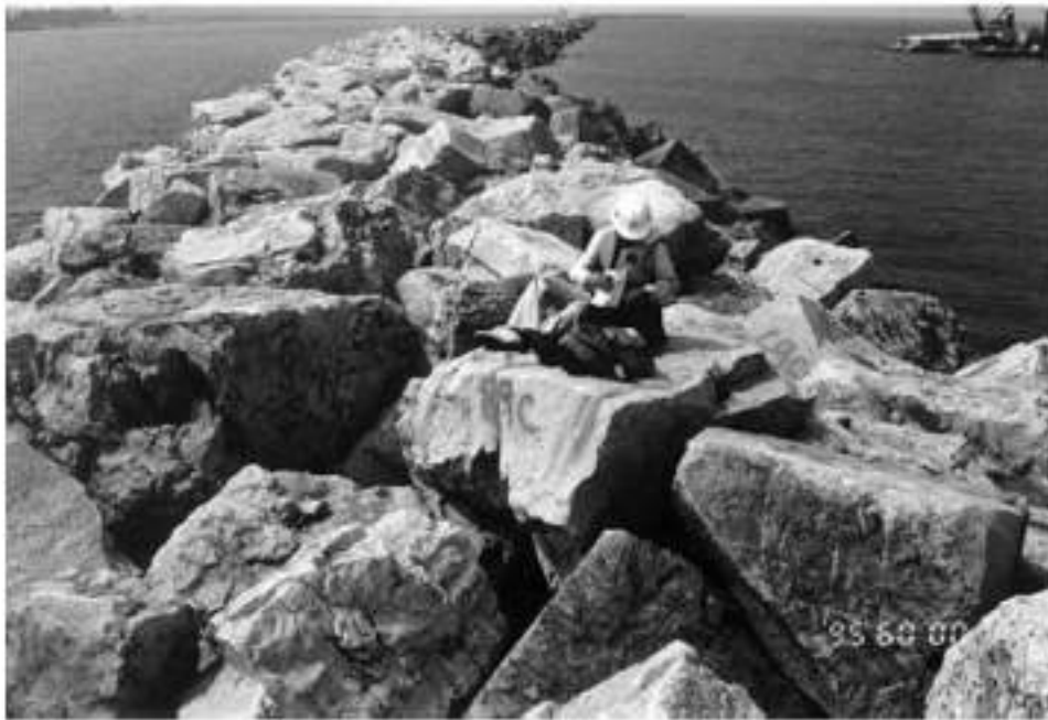
Figura 4-89 Ejemplo de enrocado colocado de forma aleatoria (Figure VI-4-2 del Coastal Engineering Manual).
